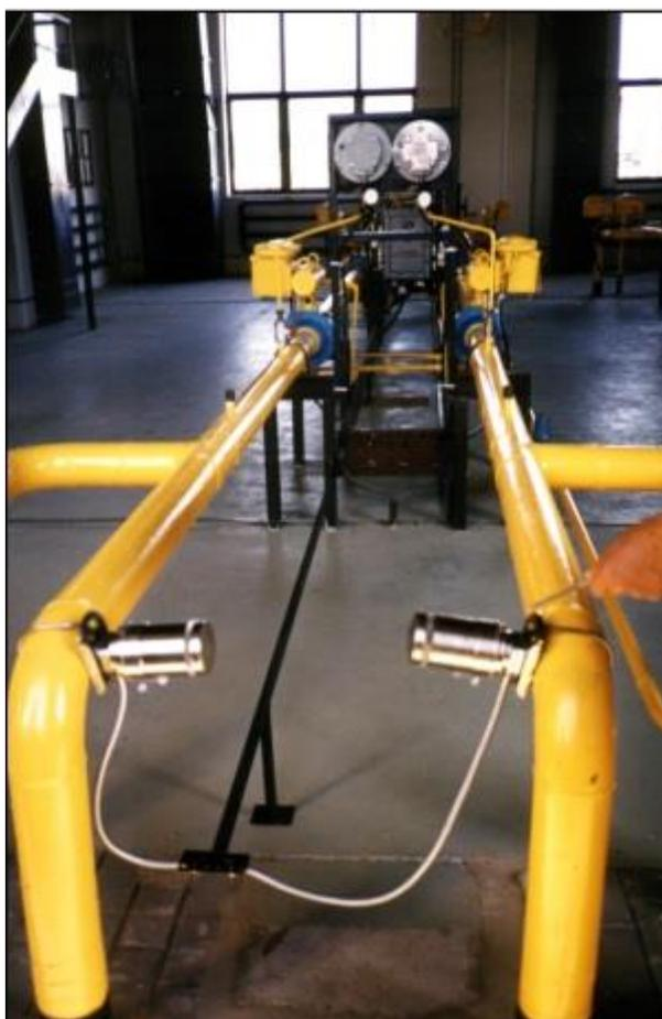
Рис. 2 - ДСП-А, установленные на ГСП-1 «Касимовского СПХГ»
